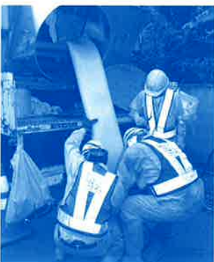
既設管に加熱軟化させた塩ビ樹脂製パイプを挿入
